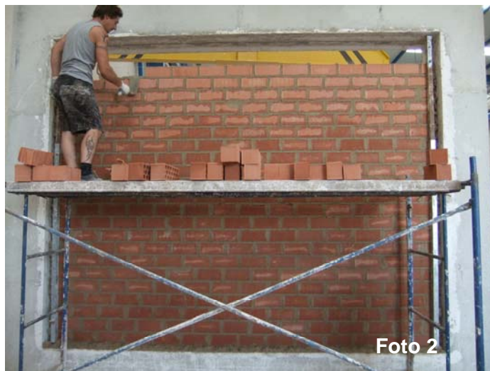
Fotos 1 y 2: Montaje de fábrica
