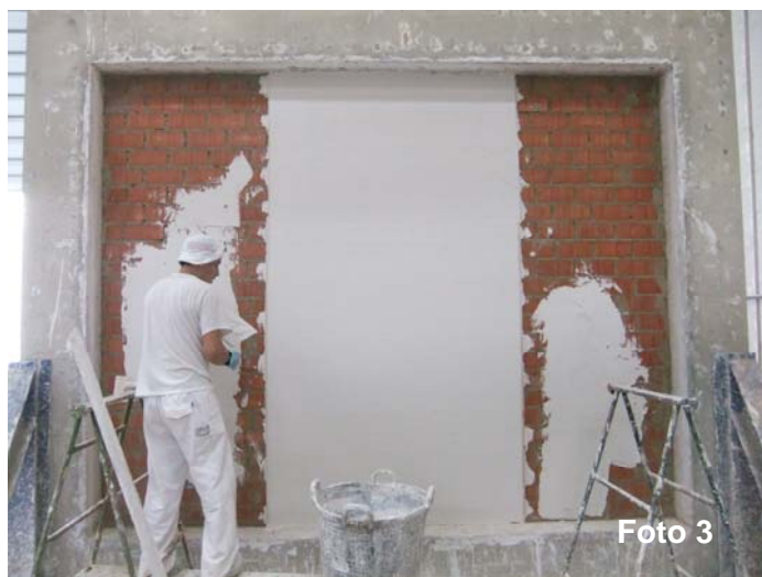
Foto 3: Aplicación de revestimiento
