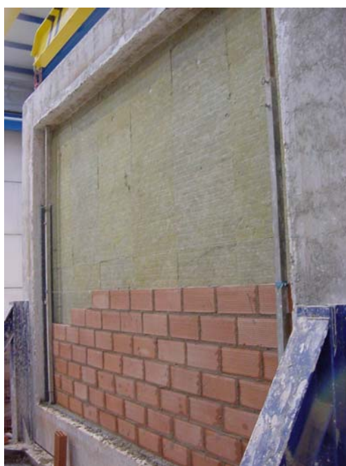
Foto 2: Construcción de segunda fábrica de LHD de 7 sobre banda perimetral de poliestireno expandido elastificado
