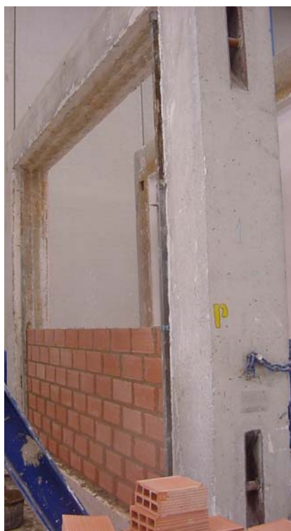
Foto 1: Construcción de la primera fábrica de LHD de 7 cm
