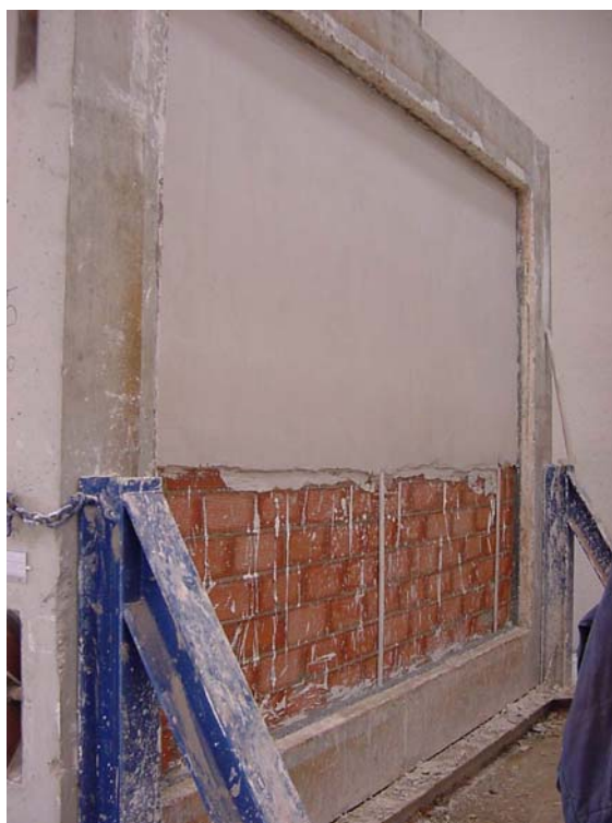
Foto 3: Guarnecido y enlucido de yeso de la fábrica de LHD de 7 sobre banda perimetral de poliestireno expandido elasticado
