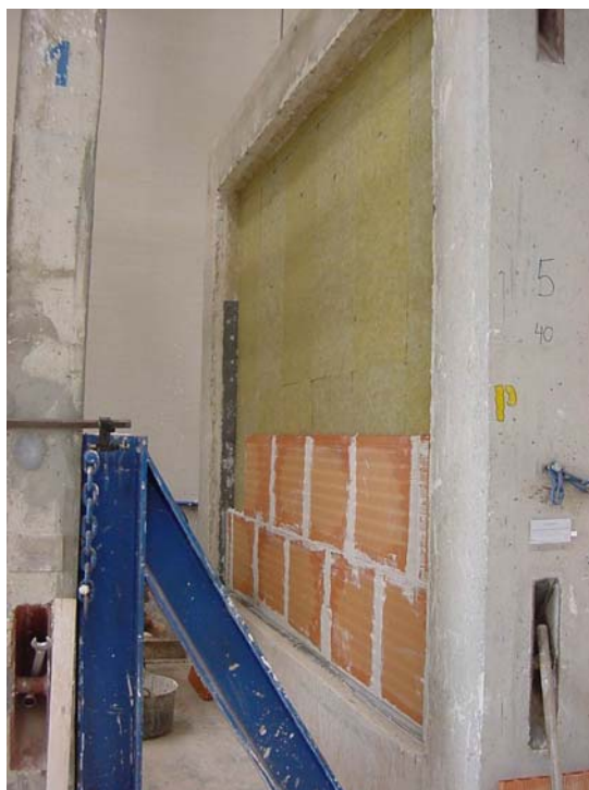
Foto 2: Construcción de fábrica de ladrillo gran formato de 5 sobre banda perimetral de poliestireno expandido elastificado
