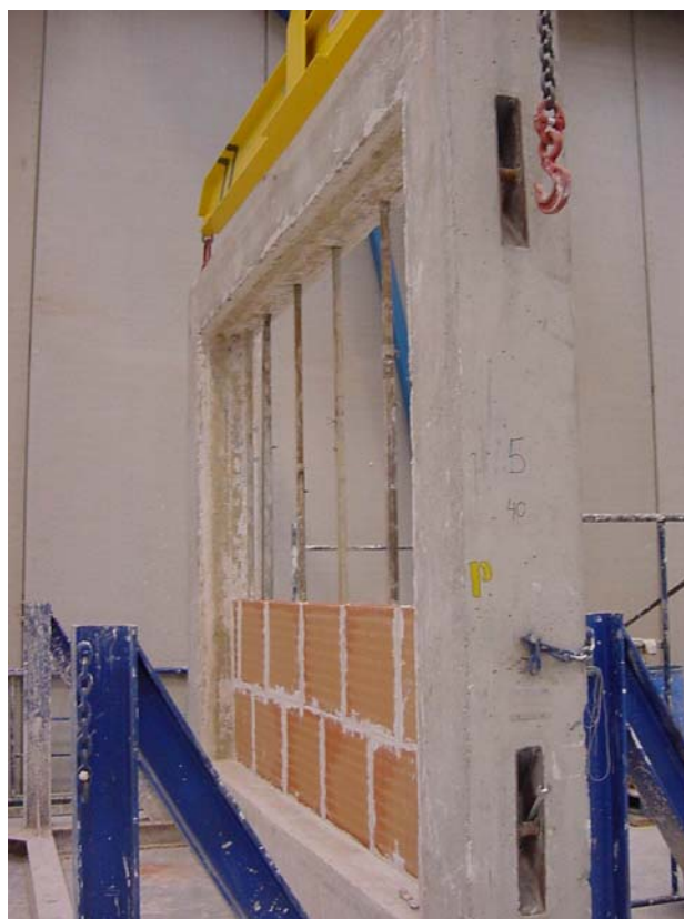
Foto 1: Construcción de fábrica de ladrillo gran formato de 7
