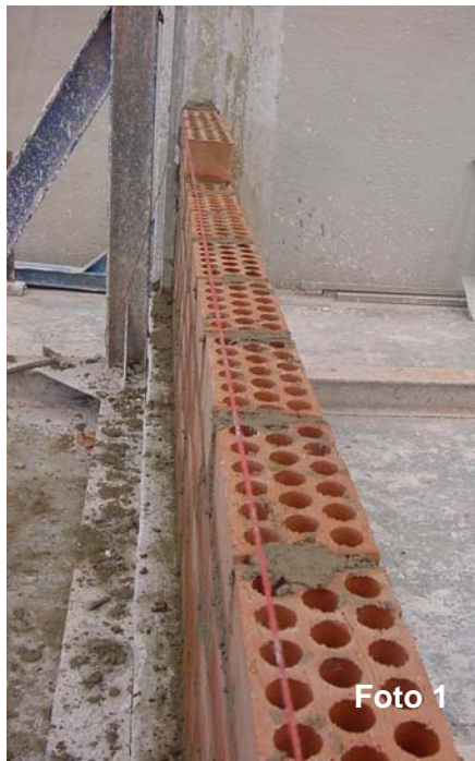
Fotos 1 y 2: Construcción de fábrica de ladrillo perforado cerámico de 11,5 cm
