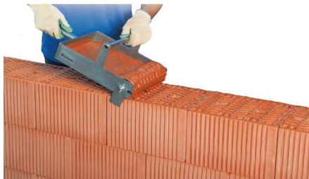
5. Aplicación de mortero rodillo
