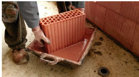
6. Aplicación de mortero untado
