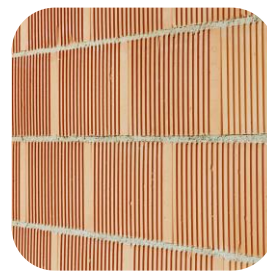
Bloque tradicional junta 10 mm
