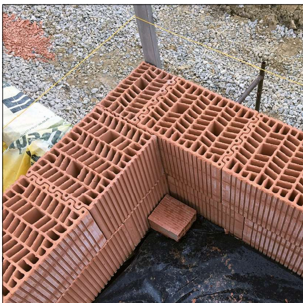
5 Esquina usando piezas lisa y medias. Válido para Ecorec® 24 y 29.
