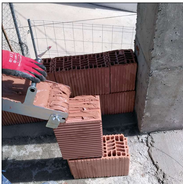
4 Aplicar en la testa del bloque.
