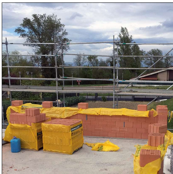
6 Proteger los muros de la lluvia.
